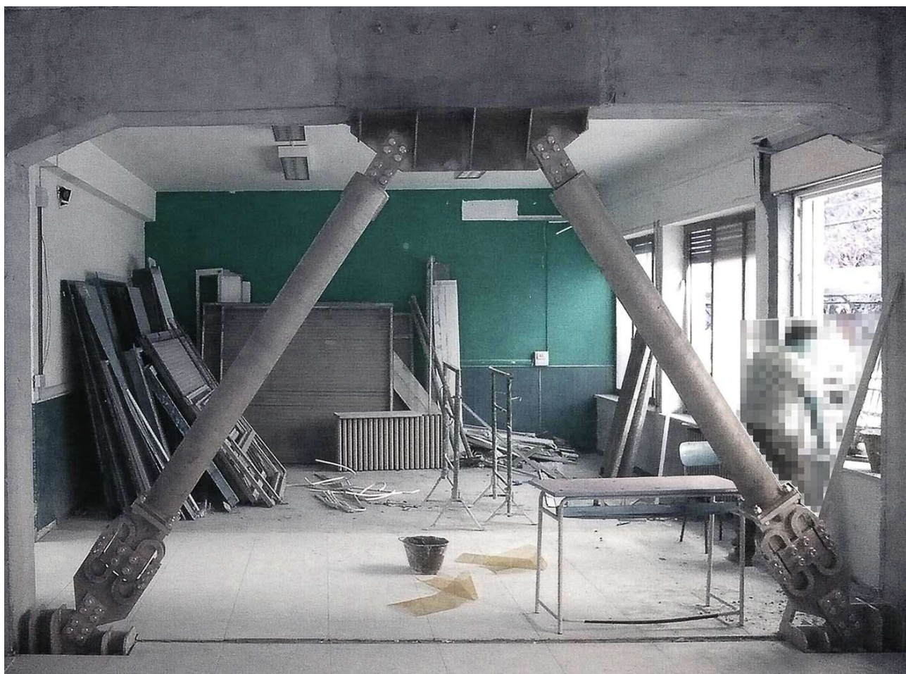
Installazione di controventi dissipativi
